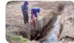
遊休農地の発生状況や施設の劣化状況等の確認
