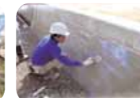
老朽化した水路のコーティング等による補修
