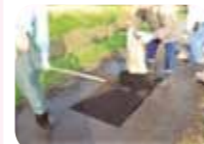
農道舗装の補修
