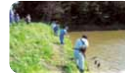
堤体の草刈り等によるため池の保全管理
