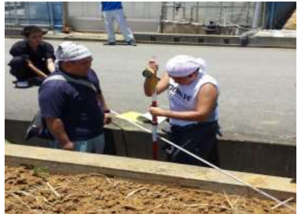
中心線測量による NO 点の復元
