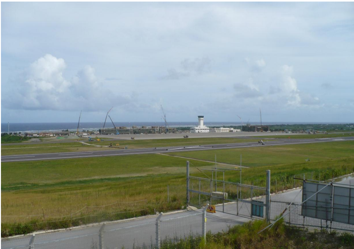
新石垣空港建設事務所から臨む空港ターミナルビル付近の遠景
