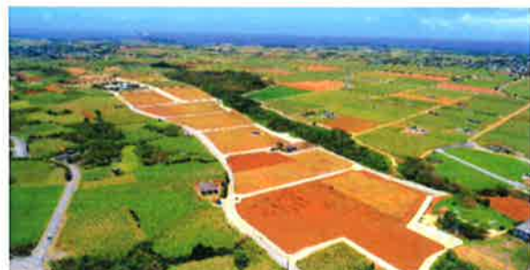
圃場整備後(宮古島市村越地区)
